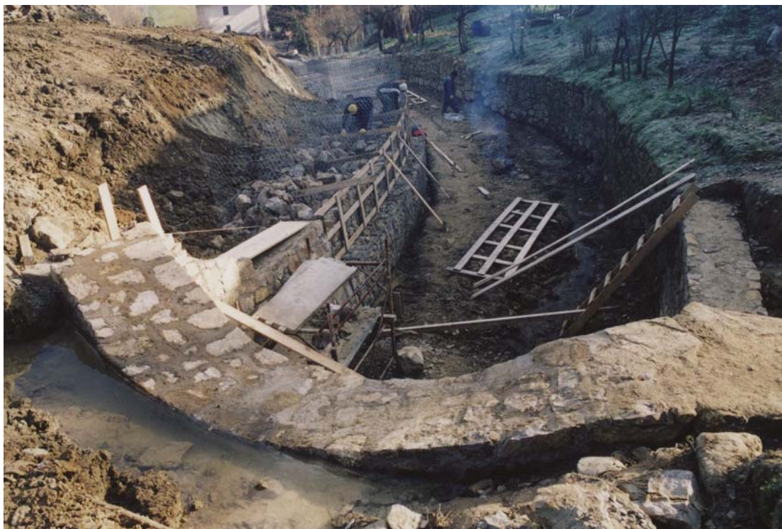
Fig.14 Lavori di adeguamento delle difese spondali e di una briglia sul torrente Chiesimone. Comune di Reggello.
