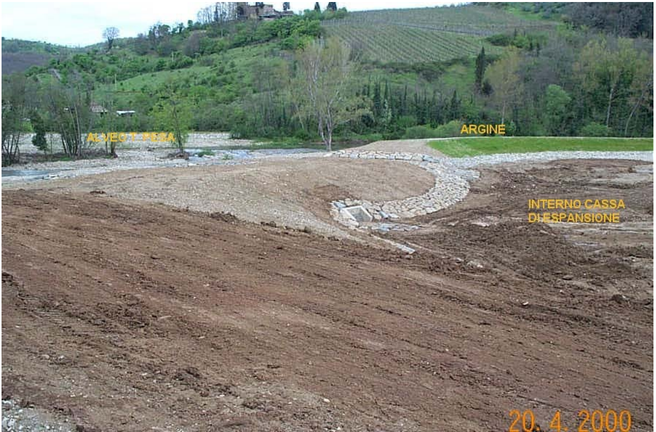
Fig.15 Lavori per la cassa di espansione e difese spondali sul T. Pesa in loc S.Donato Montecchio. Comune di Tavarnelle Val di Pesa.
