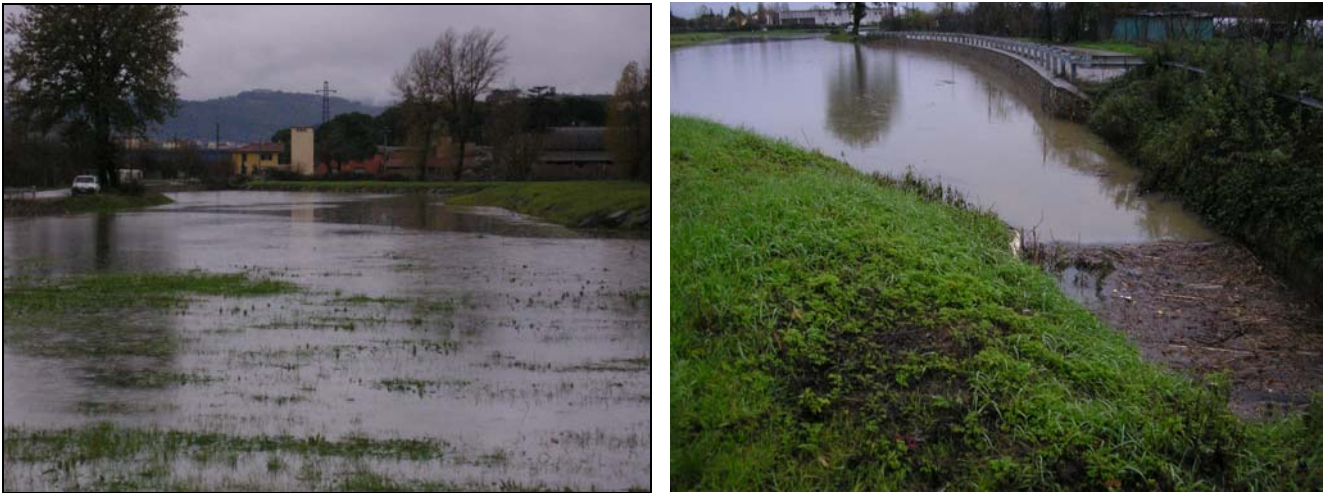
Fosso Stagno (Lastra a Signa): cassa di laminazione 27 nov 2005 h 16:00
